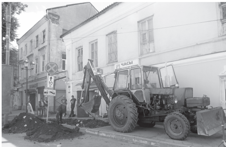
ООО «ТК Новгородская» ведёт ремонтные работы на ул. Коммунарной
