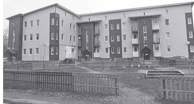
Дом № 26 на ул. Транзитной
